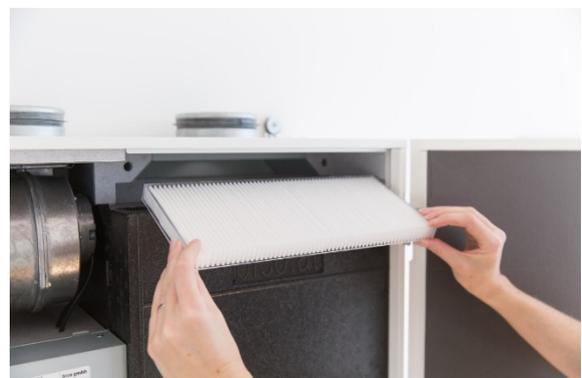
Neuen sauberen Filter einsetzen. Auf die korrekte Einbaulage achten.
