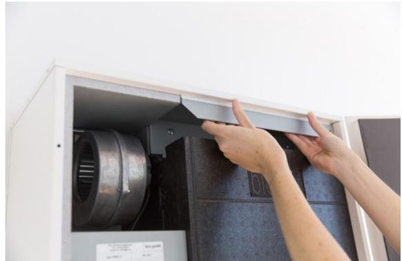
Abdeckblech leicht Richtung Gerätemitte ziehen, danach gerade nach vorne herausziehen.
