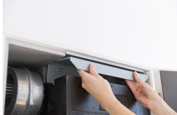
Filter ganz bis zur Geräterückwand hineinschieben. Abdeckblech wieder anbringen.
