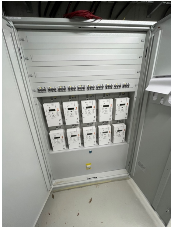
Abbildung 8 - Zählerkasten offen
