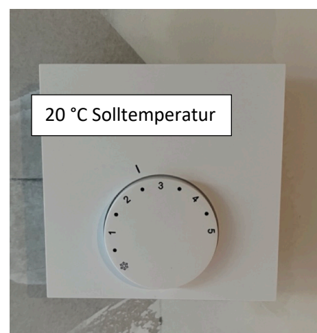
Abbildung 28 – Raumthermostat Solltemperatur
