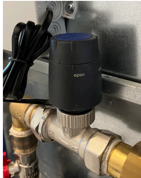
Abbildung 26 - Detail Thermostatkopf FBH
