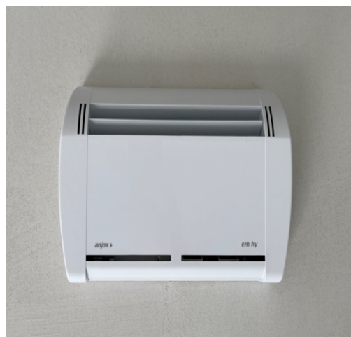
Abbildung 35 - Bedarfslüftung
