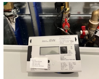
Abbildung 20 – Detail Wärmemengenzähler
