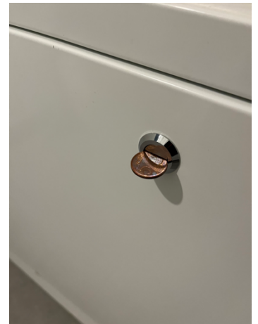
Abbildung 17 – FBH-Verteiler öffnen mittels Münze
