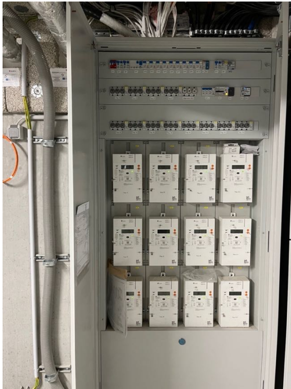
Abbildung 8 - Zählerkasten offen
