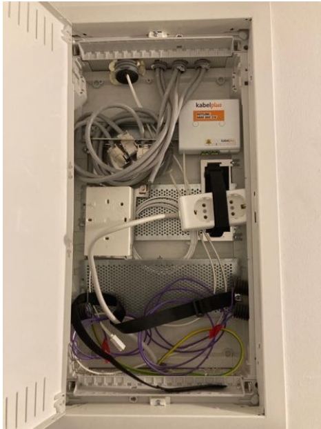
Abbildung 11 - Medienverteiler offen
