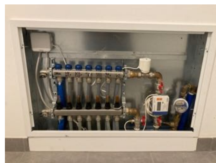
Abbildung 24 - Fußbodenheizverteiler (geöffnet)
