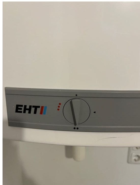
Abbildung 22 - Drehregler E-Speicher auf Standard Einstellung
