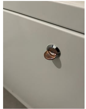
Abbildung 17 - FBH-Verteiler öffnen mittels Münze
