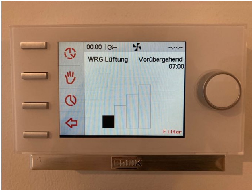
Abbildung 39 - Wohnraumlüftung Steuerung
