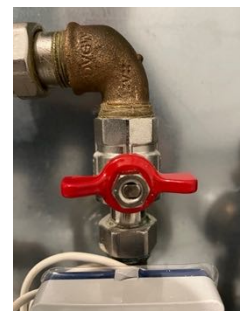
Abbildung 20 - Hebel quer zur Flussrichtung - geschlossen
