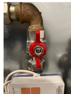
Abbildung 19 - Hebel in Flussrichtung - offen
