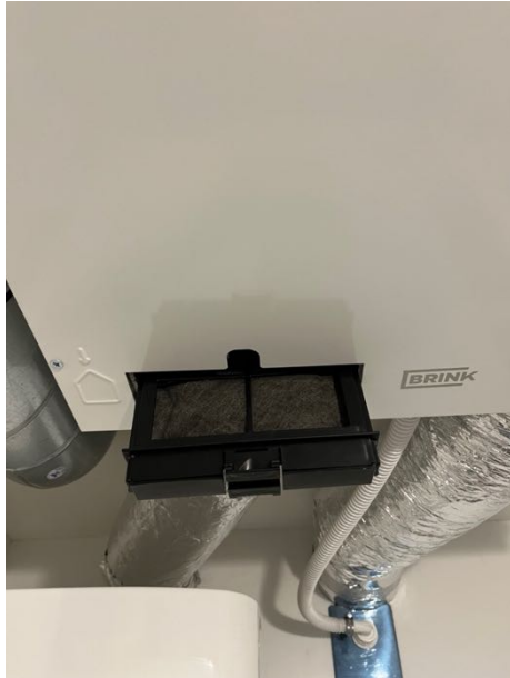
Abbildung 42 - Wohnraumlüftung – Einschub herausziehen
