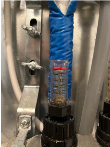
Abbildung 25 - Detail Schauglas FBH
