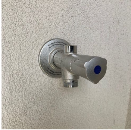
Abbildung 34 - Kemperventil
