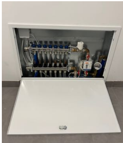
Abbildung 16 - FBH-Verteiler offen
