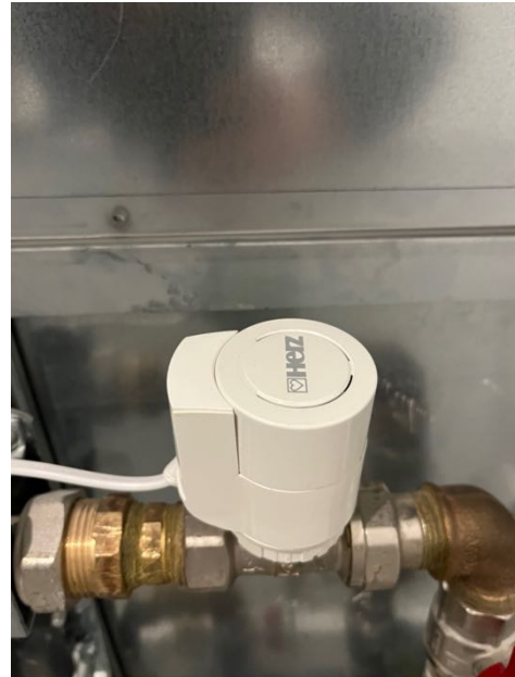
Abbildung 26 - Detail Thermostatkopf FBH
