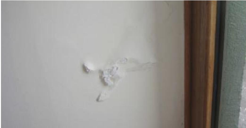
*Abb. 27 Symbolfoto von Blasenbildung an der Wand aufgrund von Feuchtigkeit*
