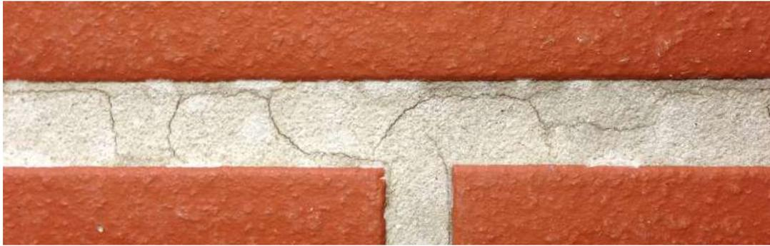
*Abb. 28 Symbolfoto einer rissigen Fuge im Außenbereich*
