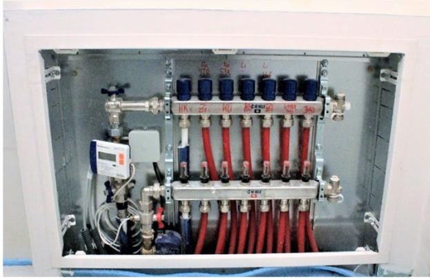
Abb. 13 Symbolfoto Fußbodenheizverteiler (geöffnet)
