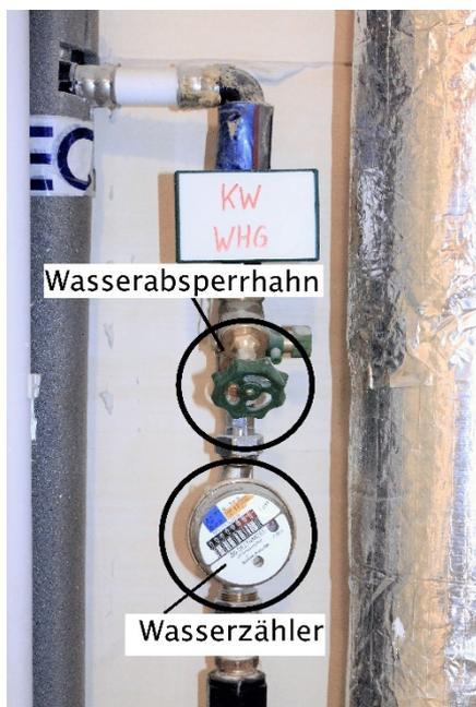
Abb. 4 Symbolfoto eines Wasserabsperrhahns und Wasserzählers im Leitungsschacht
